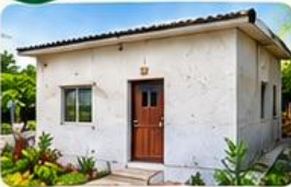
अलग कमरा / भवन
